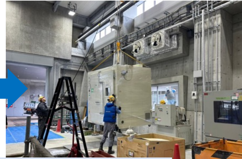
扉を外してチャンバーを新工場へ移設 Remove the door to move the chamber
