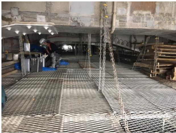
栈橋の補修工事の現場は狭く、下には海があり大変さを実感しました
