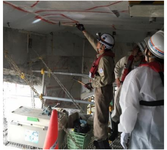
実際に打音検査をどのようにやるのか実技していただきました
